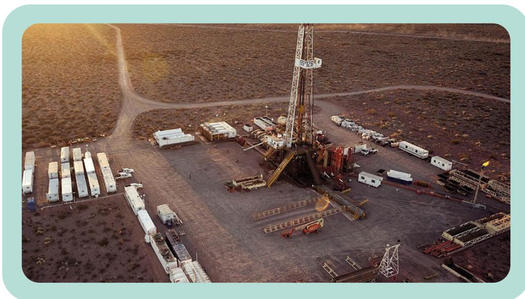
**Fotografía 9~** Plataforma de *fracking* con infraestructura auxiliar, en Vaca Muerta, Argentina<sup>14</sup>. Las plataformas son más que planchas que albergan los pozos de *fracking*. Tienen mucha infraestructura auxiliar como bodegas, parqueaderos, oficinas, talleres mecánicos, etc. y son el lugar de una intensa actividad industrial.
