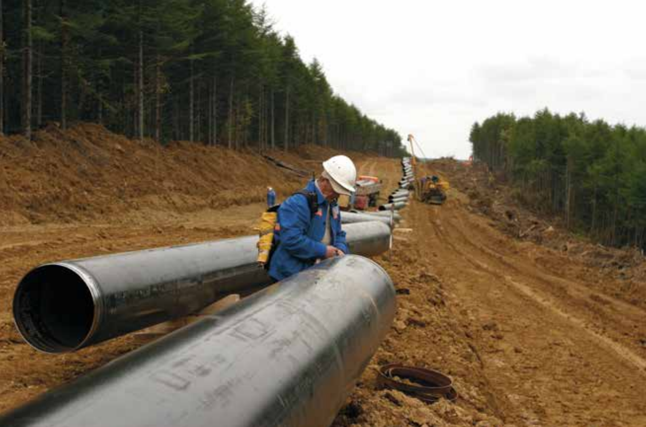
Construcción de una tubería y trabajos de cimentación para una planta de gas y un terminal de petróleo en Rusia. (© Peter Blakely – Redux/lairf)
