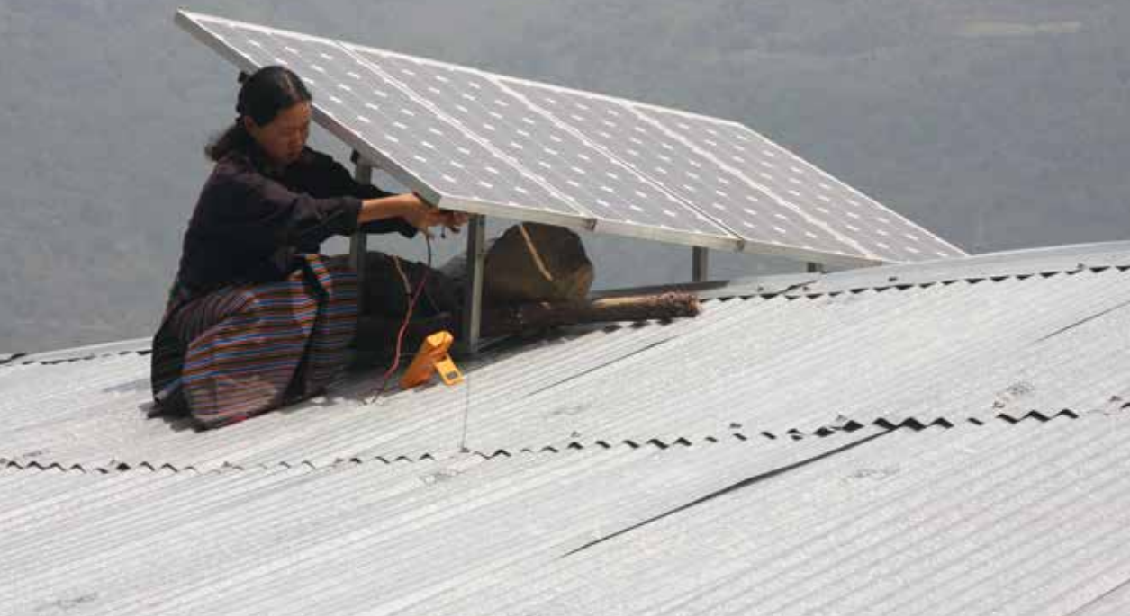
Una mujer instala paneles solares en un techo en Bután. (CC BY-NC-ND 2.0 Asian Development Bank – flickr)
